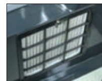
Filtro interno do ar condicionado
